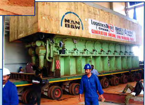
Moteur à l'intérieur de la centrale
