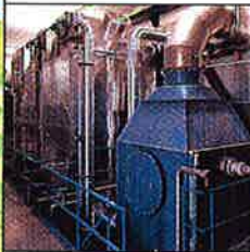
Katalysator og varmegenvinding
